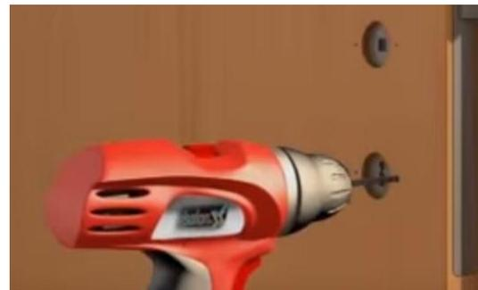
Markieren Sie die Positionen der Löcher und entfernen Sie die Schablone darauf wieder. Bohren Sie dann die Löcher.
