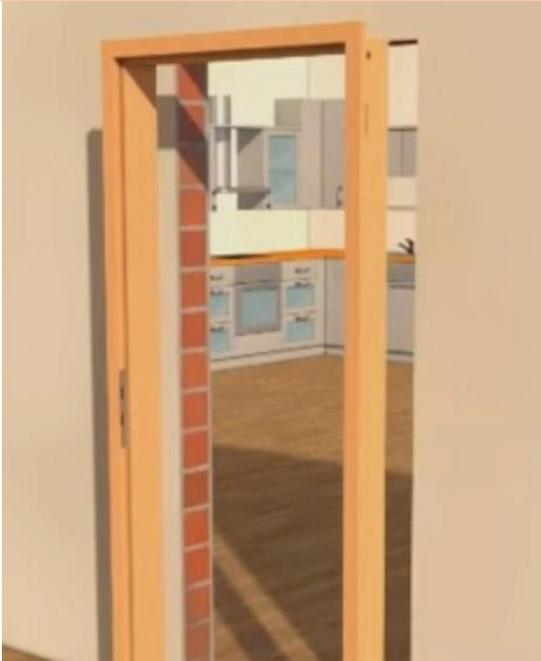
Bei manchen Fußböden sollten Sie unten etwas Luft zur Zarge lassen. Dieser Spalt wird anschließend mit Silikon versiegelt.
