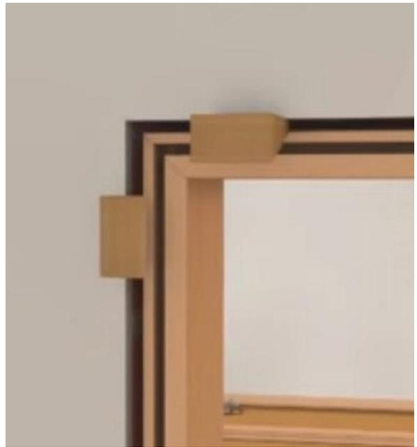
Setzen Sie die Zarge in die Türöffnung ein und fixieren Sie anschließend die Zarge in den oberen Ecken mit Holzkeilen.
