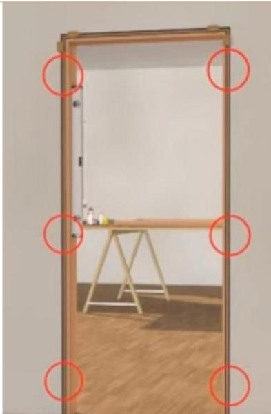
Richten Sie die Zarge mit Hilfe einer Wasserwaage waagrecht und lotrecht aus. Hinterfütern Sie den Spalt zwischen Zarge und Mauerwerk im Bereich der Bänder und des Schlosses.
