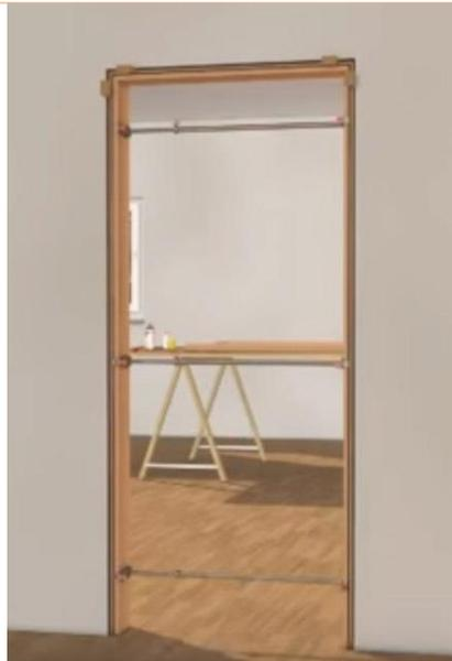
Setzen Sie anschließend an den hinterfüterten Stellen die Türspreizen an.
